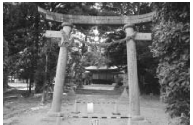
図5 2009年中国・九州北部豪雨災害時の土石流による山口県防府市右田剣神社の鳥居の被害状況 写真右側からの土石流の襲来によって変形し、柱の貫部が損傷して落下した。
