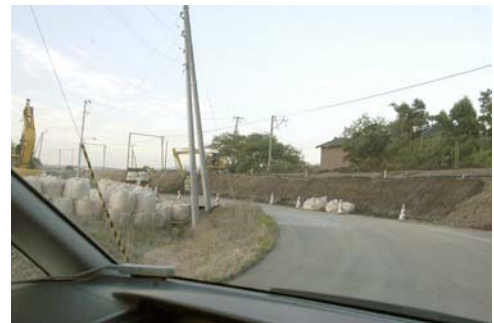
第 7 図 JR 越後線の崩壊した盛土
