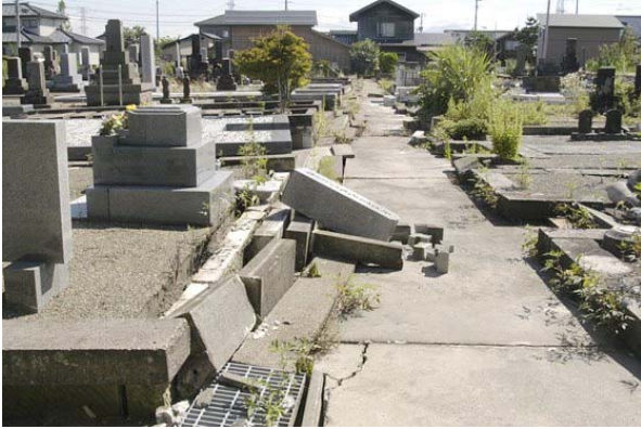
第 3 図 腰石や外柵は各区画北西側のものの破損状態が大きい。また墓地内の道路は東にスラストアップしている。奥の墓石の棹石は南東側に転倒しているが、手前の墓石は、逆に北西側に転倒している。
