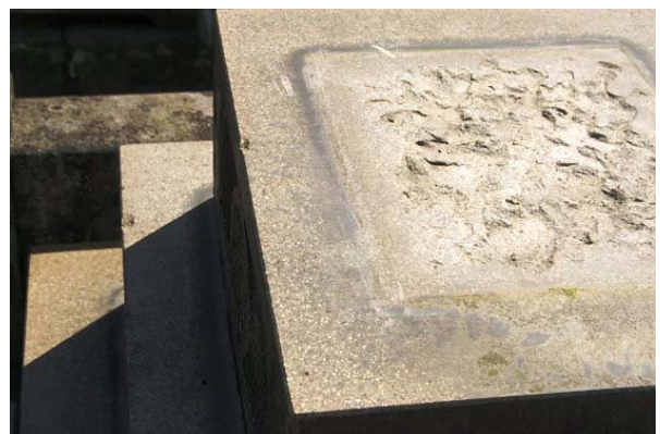
第 6 図 棹柱がロッキング現象をおこしてカタカタと動いたあと、南東方向に移動し、そのまま飛び去ったと思われる上台の損傷傷。上台および中台の鋭い損傷痕は、傷のない周囲と同様に汚れていて、古い傷(おそらく 2004 年新潟県中越地震の際かそれ以前にできたと思われる)。
