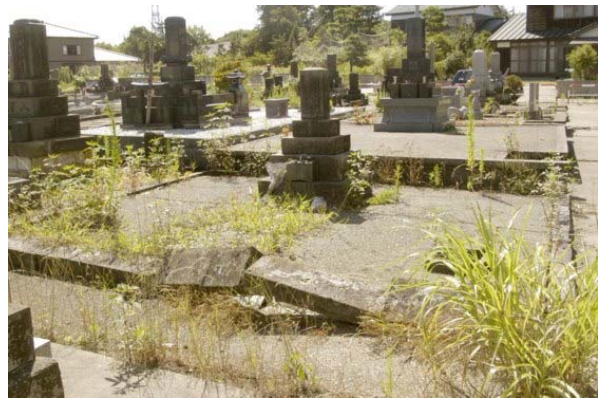
第2図 墓石自体は古いものも含めて被害は少ないが, 各区画境界の腰石や道路などから見ると, 全体として傾斜している南東側に移動していることがわかる.
