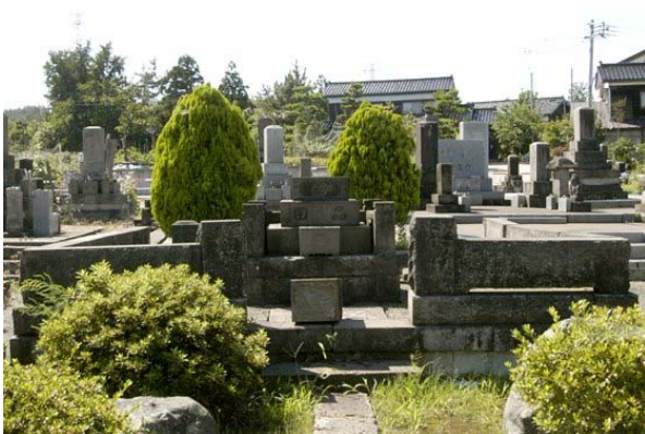
第 5 図 棹柱が遠位を底面にして、墓石正面の南東方向にまっすぐ飛んで壊れた墓石。墓地全体では、同程度の築年代やそれより古い墓石も含めて、被害を受けたものが少ない中で、竿柱が転倒した墓石が目立つ。おそらく 2004 年新潟県中越地震の際の被害によって耐震補修がおこなわれた結果であると思われる。
